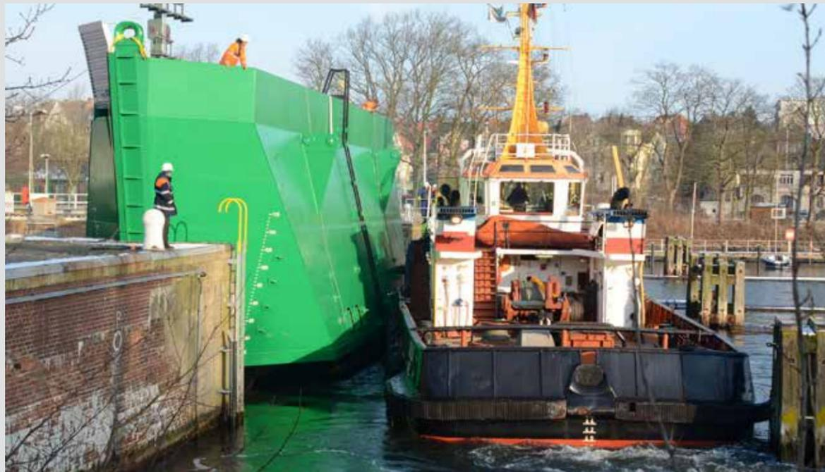
Einsatz der Torverschlüsse zur Instandsetzung der kleinen Schleusen Kiel-Holtenau
