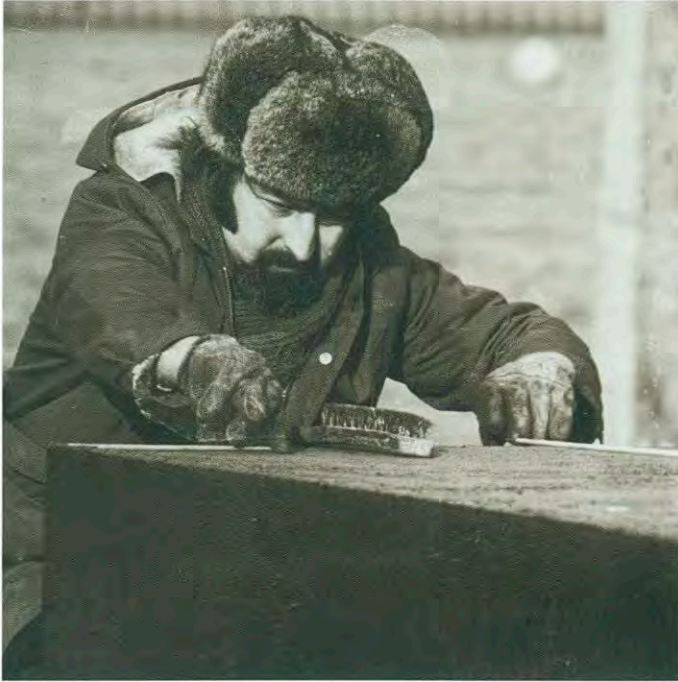
Bild oben: „Manni Bünger“ beim Nachbessern der Nuttelmann-Anlage. Bild unten rechts: Die BYC- Anlage an der Lesum nach einer Winter-Sturmflut.
