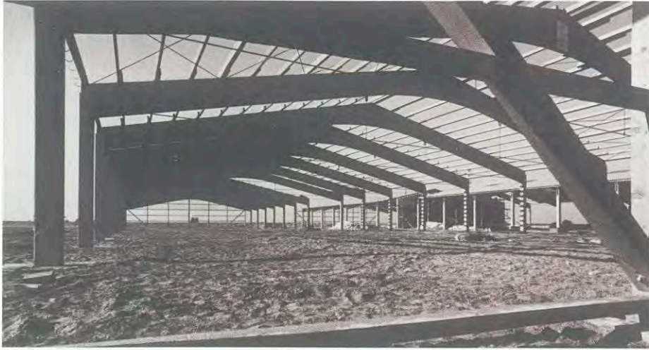
Bild oben: Hallenneubau in Hasenbüren. Eine Leimbinderkonstruktion von Fa. Hocke. Architekt Richard Päsler.
